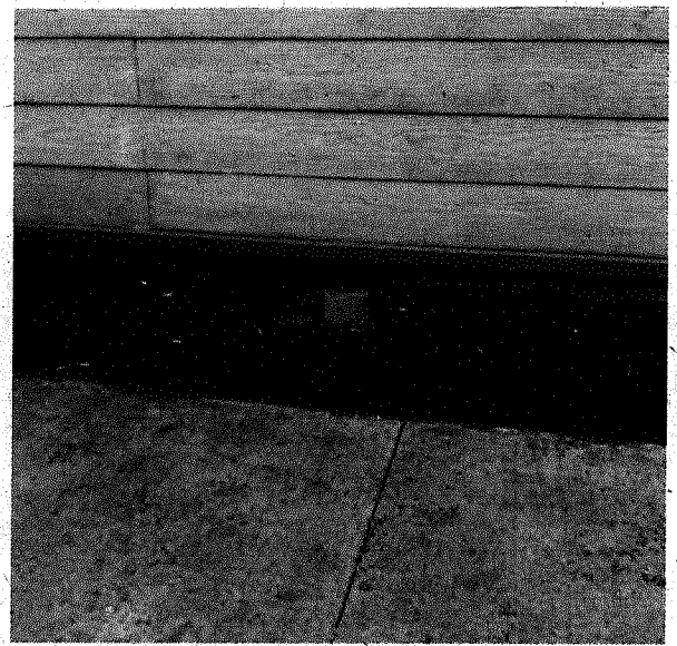
Fotografía N° 2: Sobrecimiento a la vista, sin notarse retorno de aislapol desde fundaciones.
