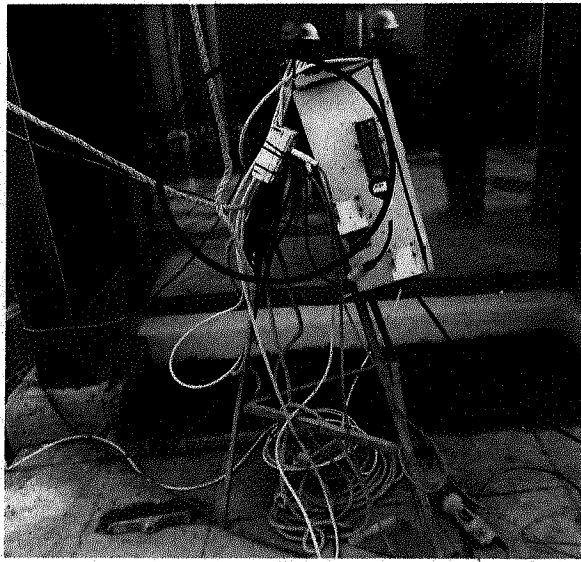
Fotografía N° 5: Enchufes de tipo domiciliario para conectar herramientas.
